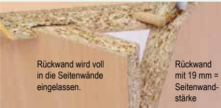
Rückwand wird voll in die Seitenwände eingelassen.
